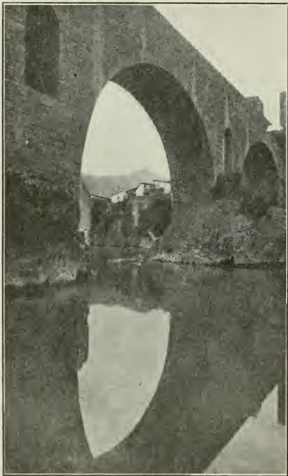
Un arc del pont de Besalú
